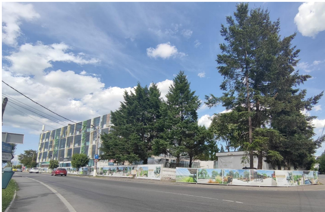
Fig. 7. Fosta fabrică de confecții, în pregătirea convertirii în proiect imobiliar cu funcțiuni rezidențiale și comerciale. Sursa: foto autor.
